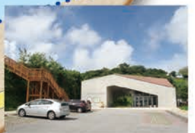
南エントランス
